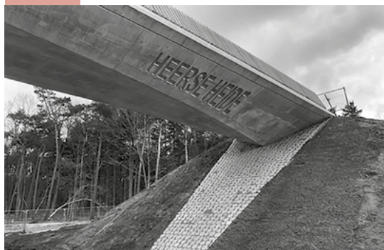
↑ Voetgangers-fietsbrug bij Heerse Heide, zeer slanke constructie alleen mogelijk met voorspan.
