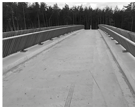
↑ Voetgangers-fietsbrug bij Heerse Heide, zeer slanke constructie alleen mogelijk met voorspan.
