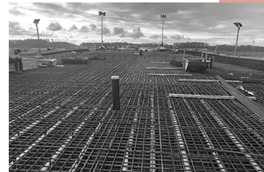
↑ Wapening van het laatste dek van een brug welke nog moet worden gestort. De zilveren buizen zijn voor de doorvoer van de voerspankabels.
